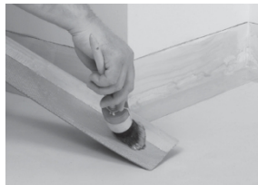
Aplique cola no chão e contra a parede até à linha.
