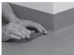
Recortar o revestimento do pavimento que será colocado Trabalho efectuado em cima do rodapé
